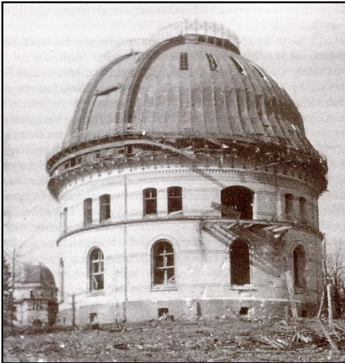
Das beschädigte Kuppelgebäude April 1945
