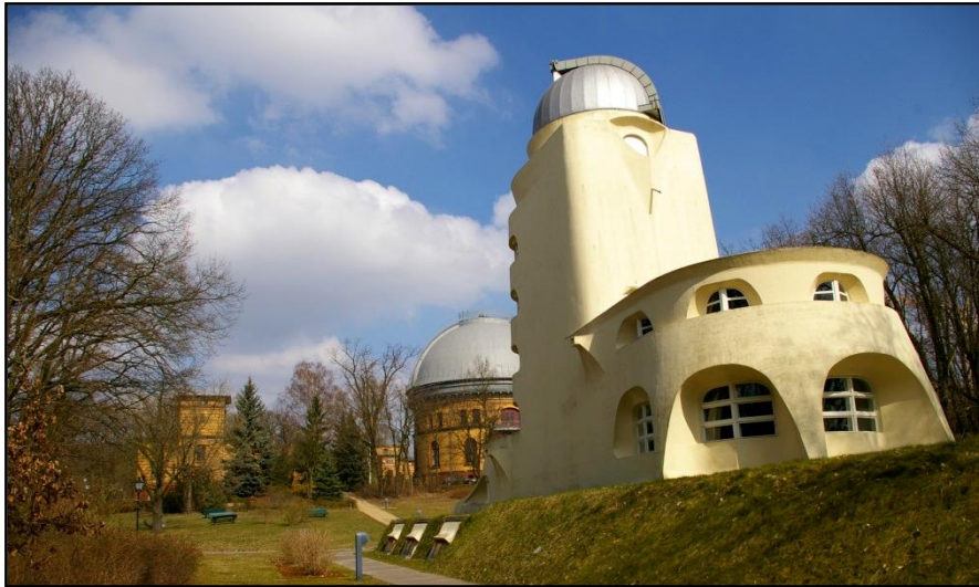
Ansicht von Süden; im Hintergrund das Kuppelgebäude des Großen Refraktors
